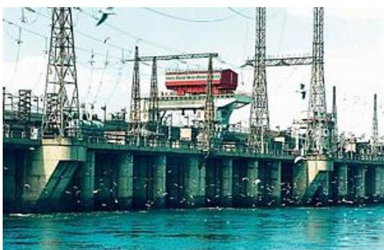
Основой гидроэнергетики Украины являются ГЭС-ГАЭС Днепровского каскада суммарной установленной мощностью 3148,6 МВт. Основным регулятором стока воды в Днепре является Кременчугская ГЭС, полезный объем водохранилища которой составляет 9 млрд. куб. м.
